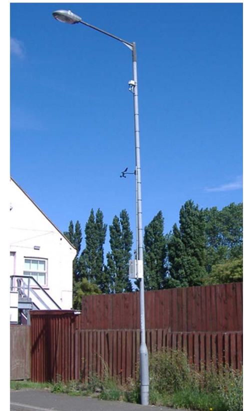
Osiris Dust Unit
